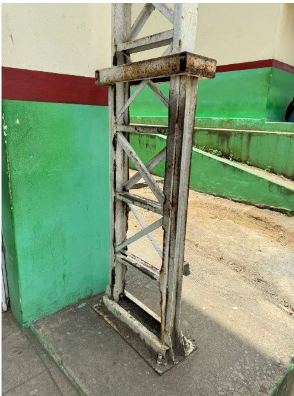
Corrosão em pilares, tanto no pilar original quanto no reforço;
