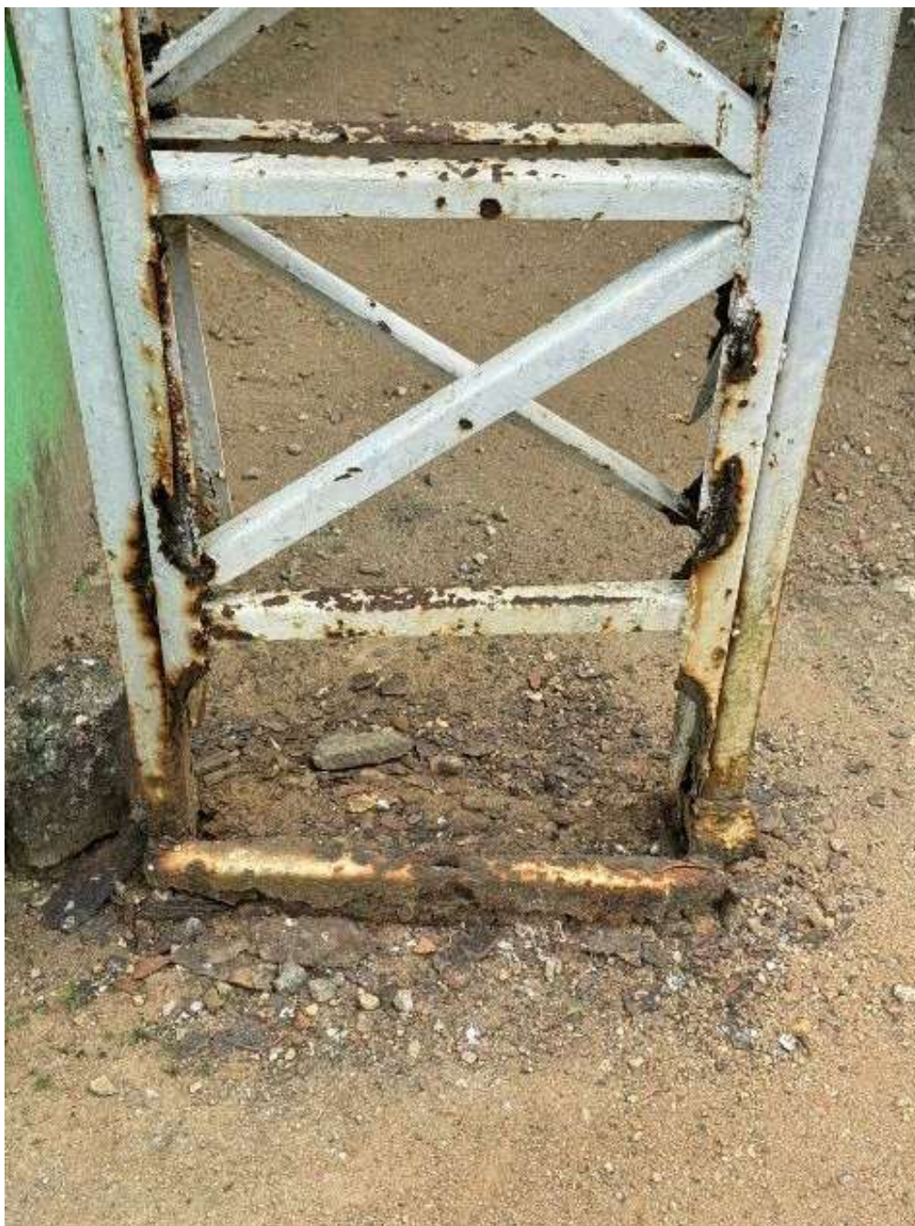
Base de pilar com grave corrosão;
