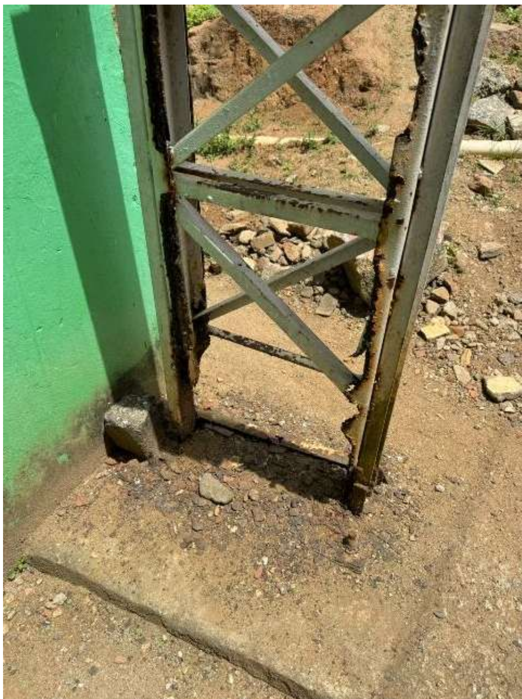
Pilar metálico com corrosão severa na base;
