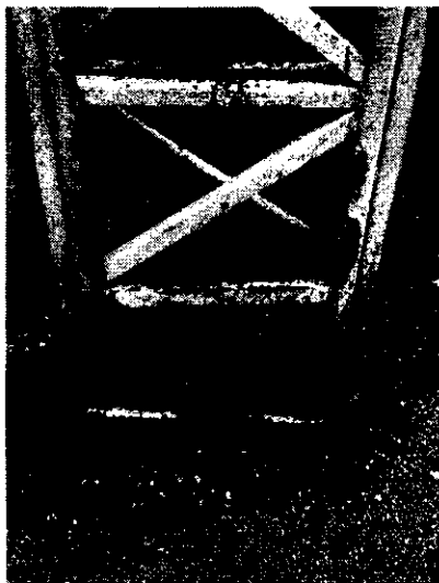
Região de solda com perda de material.
