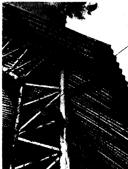
Travamento lateral comprometido pela oxidação.
