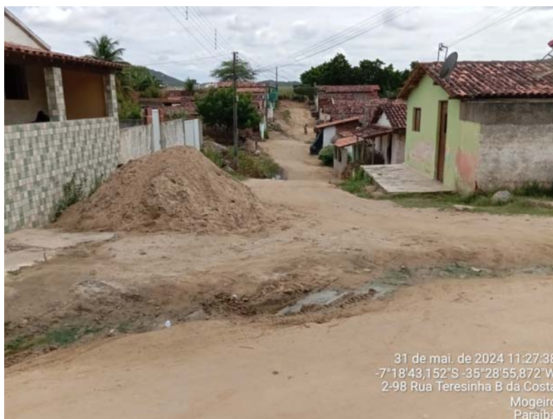
Figura 7 - RUA JOSÉ DOMINGOS DE SOUZA
