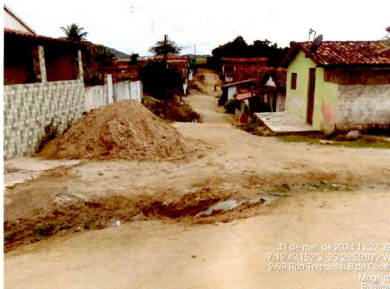
Figura 5 - RUA JOSÉ DOMINGOS DE SOUZA
